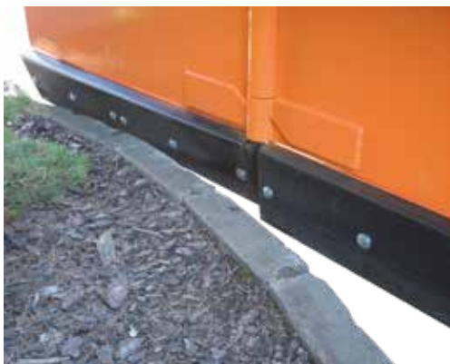
Protection par ressorts (petites lames inclinables)
