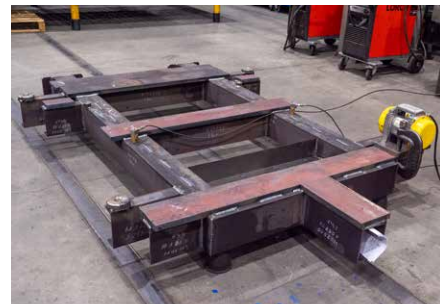
▲ Odprężanie wibracyjne elementu konstrukcyjnego oprzyrządowania
