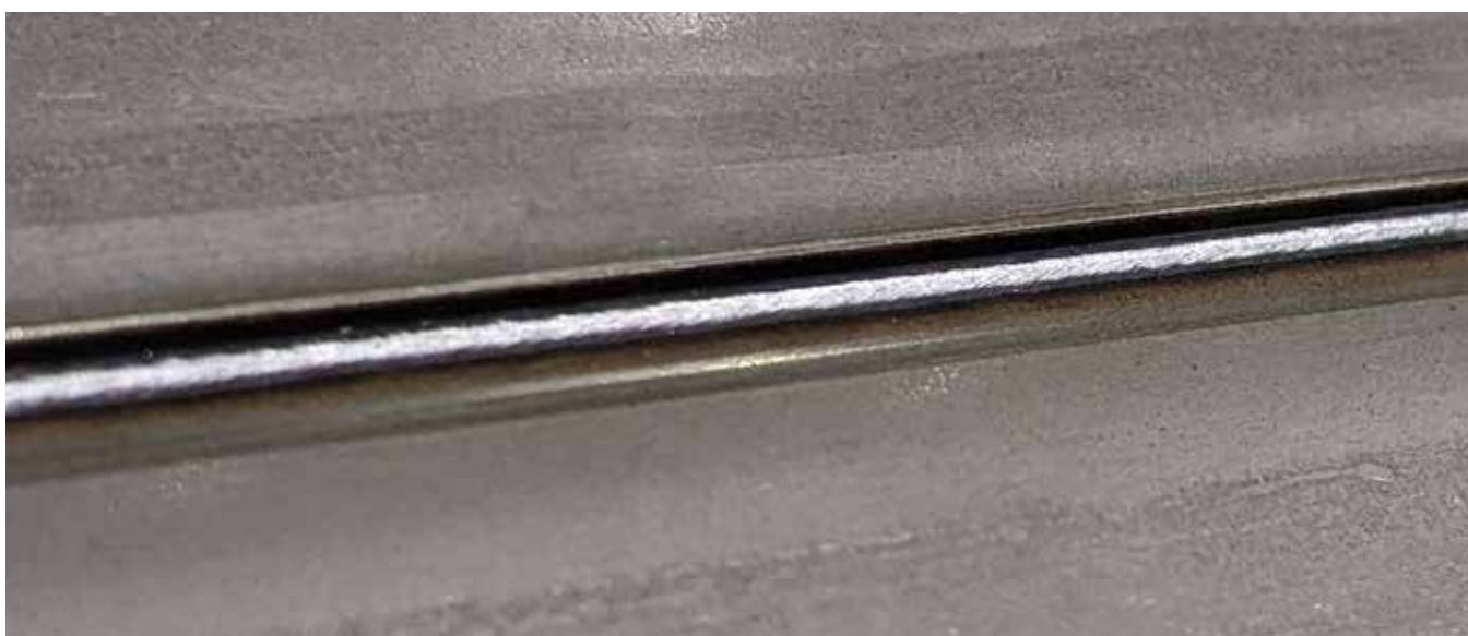
▲ Spoina wykonana metodą zautomatyzowanego spawania laserowego
