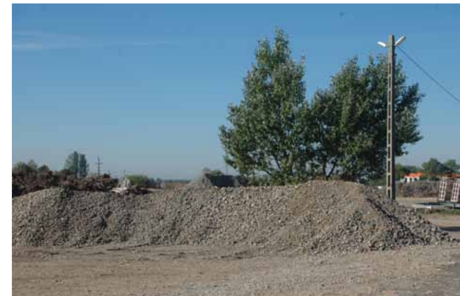
Gruz budowlany, poddany odpowiedniej przeróbce, posłużył do budowy ścieżki rowerowej w miejscowości Nyiregyhaza
